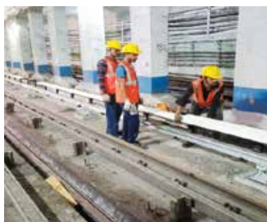
कोलकाता मेट्रो में एल्यूमिनियम थर्ड रेल का स्टील थर्ड रेल के साथ प्रतिस्थापन
