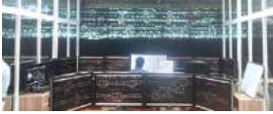
उत्तर मध्य रेलवे के टुंडला में केंद्रीकृत यातायात नियंत्रण प्रणाली
