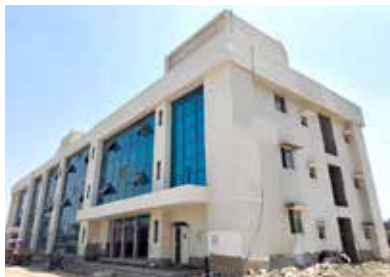
एबीएसएस के अंतर्गत मुजफ्फरपुर स्टेशन का संयुक्त टर्मिनल भवन
