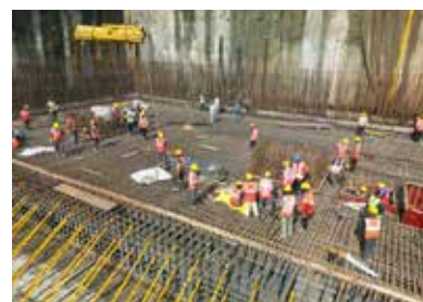
निर्माणाधीन मुंबई बुलेट ट्रेन स्टेशन
