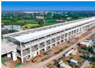
गुजरात में निर्माणधीन आणंद बुलेट ट्रेन स्टेशन
